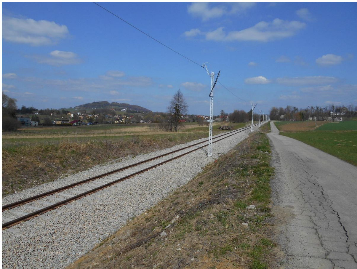
Szlak Goleiszów – Cieszyn w miejscowości Goleiszów przed zawieszeniem sieci trakcyjnej. Stan na kwiecień 2022.
